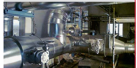
Isolierungsarbeiten im Kraftwerk Eisenhüttenstadt
