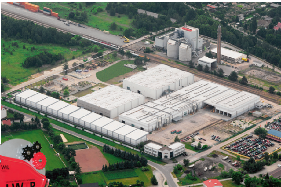
Sieger LWTP 2015 Fa. BOSIG in Elsterwerda mit optimierten Verfahren zur Fertigung von Balkonplatten.
